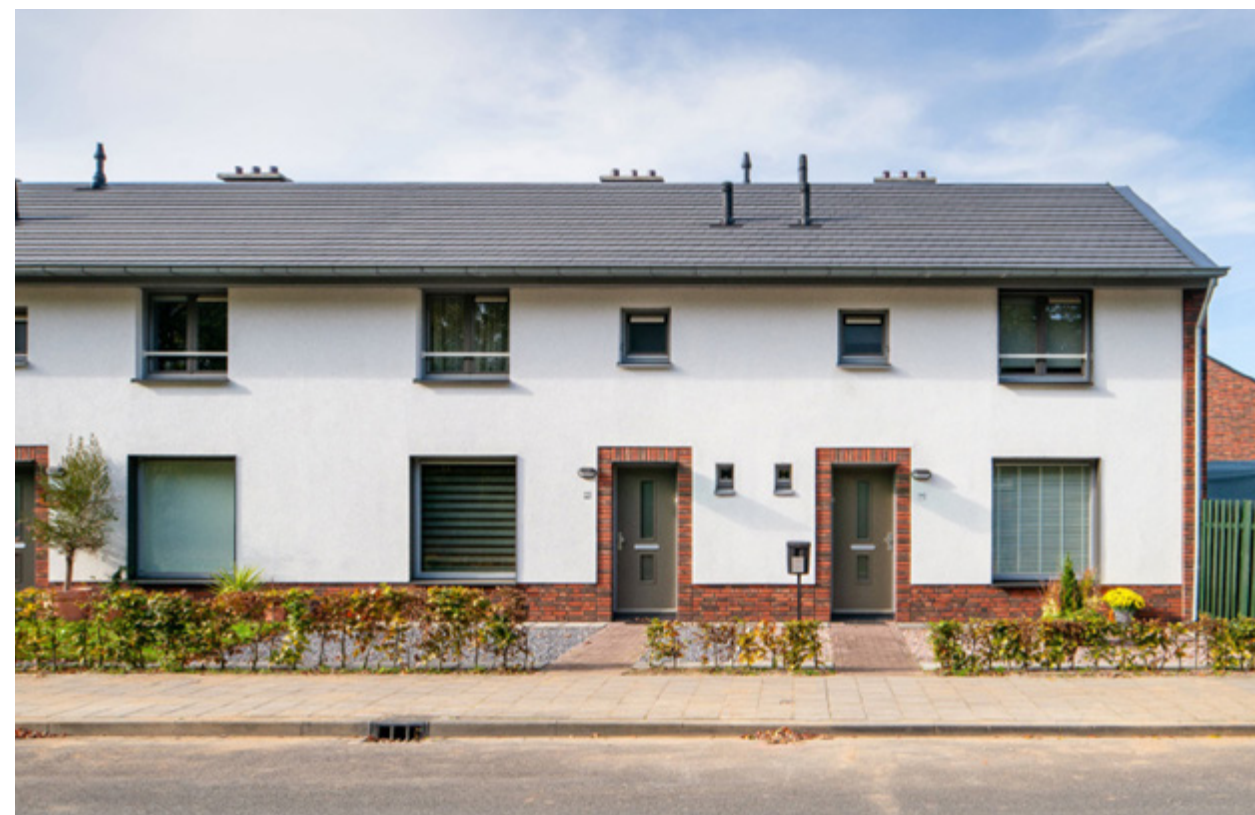
Verduurzaamde woningen van woningbouwcorporatie in Nazareth als voorbeeld van een planmatige en gebiedsgerichte aanpak.
