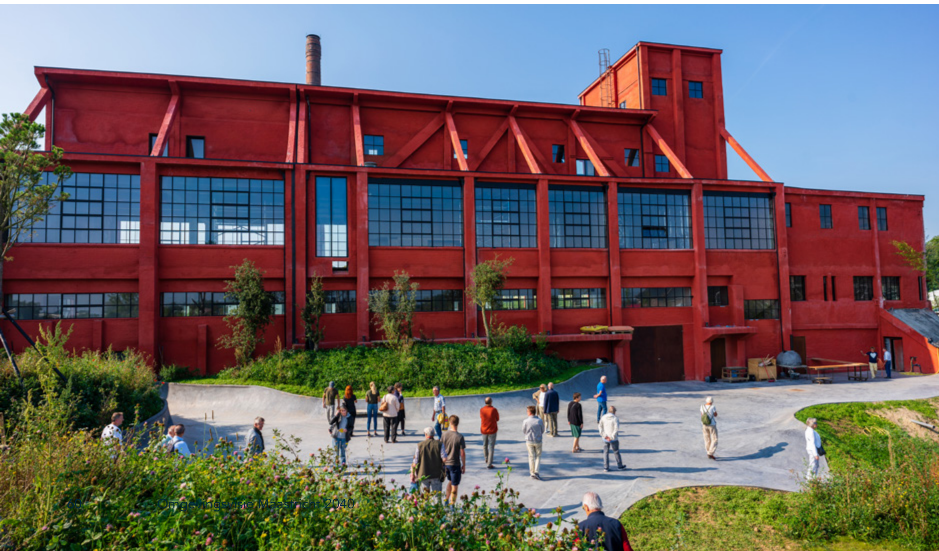
Hergebruik cultureel erfgoed op 't Radium, onderdeel van Gebiedsontwikkeling Belvédère. Foto: Fred Berghmans
