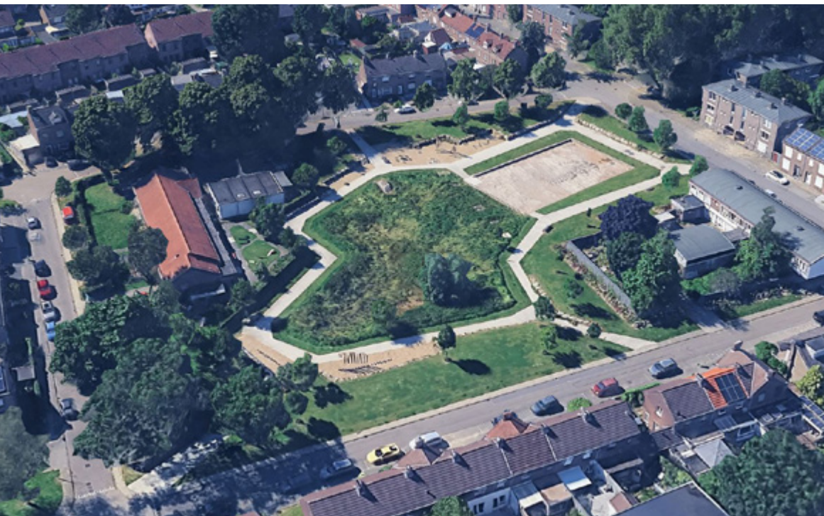
Figuur 12: Referentieproject herinrichting Plein St. Petrus Banden in Heer tot park met ondergrondse waterbuffer (ontwerp Caspar Slijpen)
